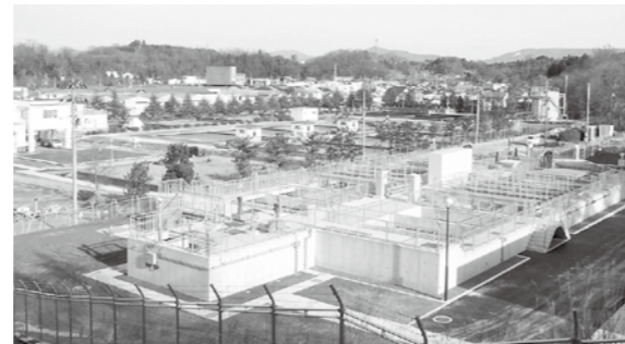
皆さんのもとへ安全・安心な水を届けています(西川浄水場前処理施設)
