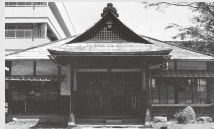
解体直前の行在所(左奥に旧市庁舎が見えます)
