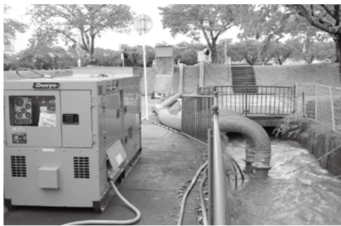
平成29年10月23日・卸町団地での内水排水作業。現在、浸水被害軽減のための工事を進めています
