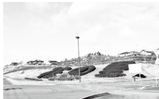
ながぬまニュータウン(国道118号沿い)
