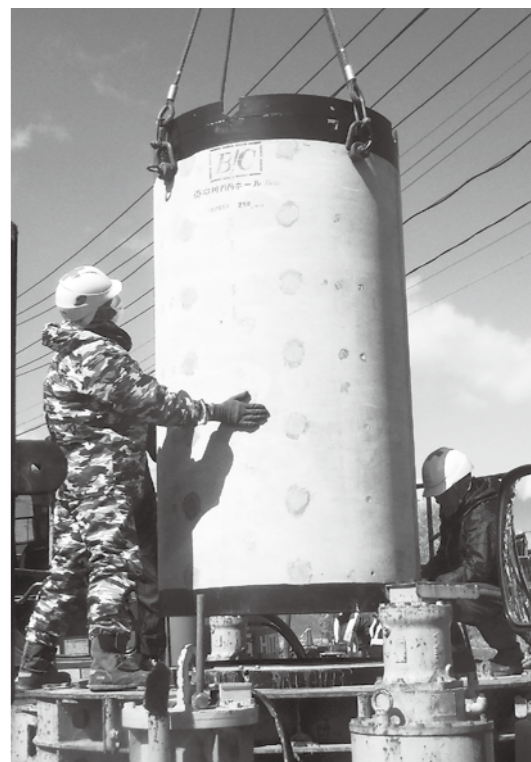
マンホールは大きい！(下水道工事の様子)
