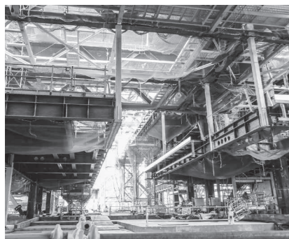
完成に向け、工事が進められています
