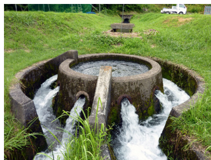
写真 2-28. 安積疏水白江幹線円筒分木工
