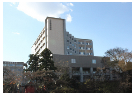
写真 2-27.公立岩瀬病院
