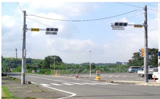
↑設置された押しボタン式信号機
