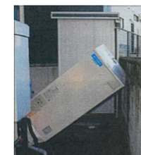
【給湯器の被災状況】
