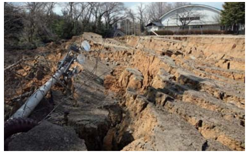
第一小学校の校庭崩落
