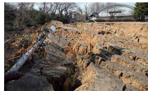
第一小学校の校庭崩落
