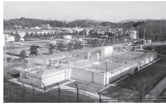
安全・安心な水を届けています(西川浄水場前処理施設)
