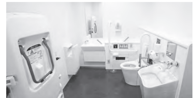
新設したオストメイト機能付きバリアフリートイレ
