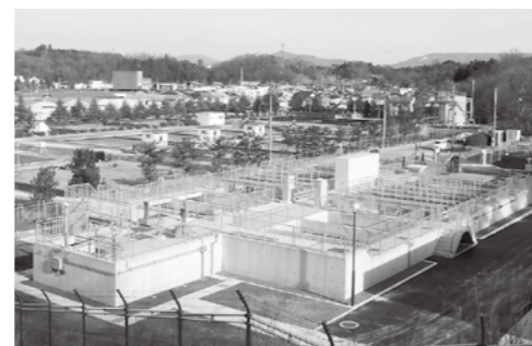
安全・安心な水を届けています(西川浄水場前処理施設)
