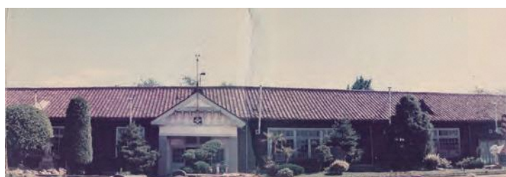
解体前の木造校舎 （昭和52年）
