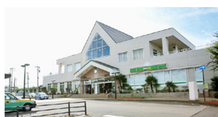
東西自由連絡通路が整備される須賀川駅
