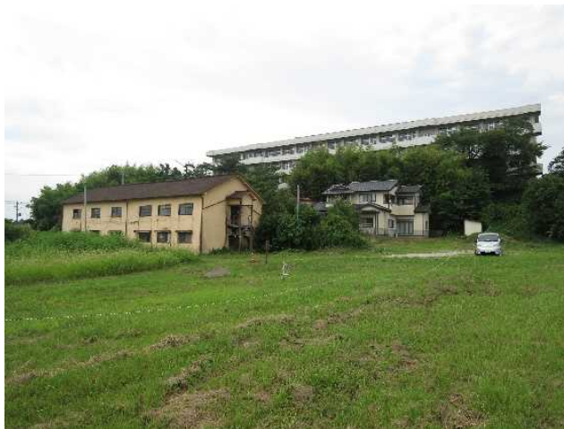
第26図 史跡からみた第二中学校（南から）
