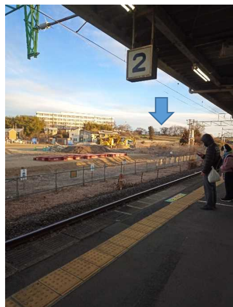
第62図 JR 須賀川駅東北本線ホームからみる史跡の現況
