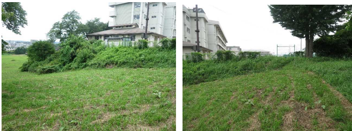
第 109 図 史跡と須賀川市立第二中学校境界付近の現況
