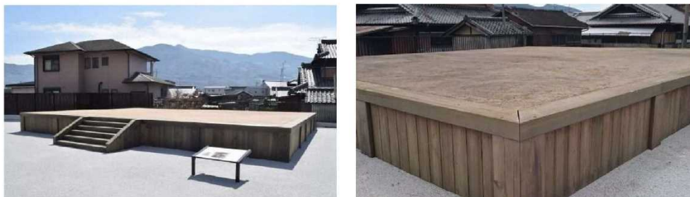
参考写真 1 木製基壇復元事例 (史跡佐野寺跡：和歌山県かつらぎ町)
