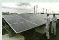
太陽発電設備の検査の様子
