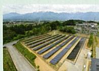
リユース品を使用した発電所
