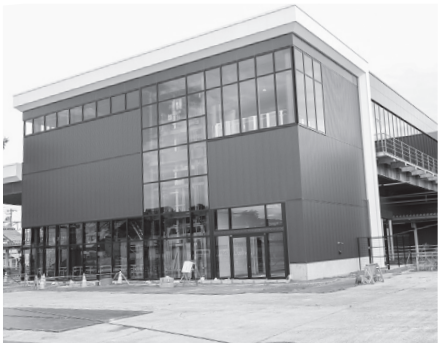
整備中の須賀川駅東西自由連絡通路
