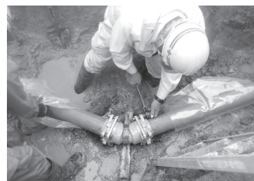
水道管路を更新する工事の様子
