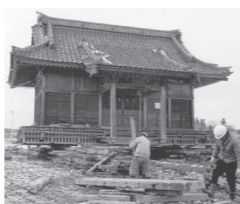
社殿を移動させるため、建物を持ち上げる様子
