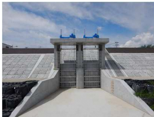
石塚排水樋門（大河原排水区）
