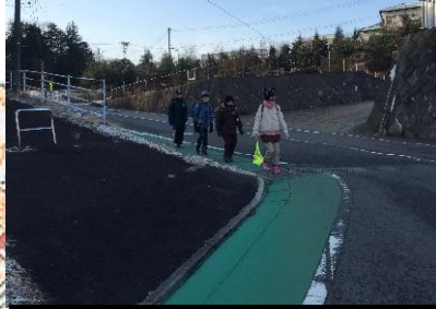
②道路が狭く歩道もないので路側帯カラーの再塗装を実施済 (H25)
