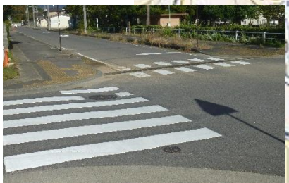
③横断歩道の道路標示が薄くなり、見づらいため、横断歩道の引き直しを実施済 (H26)
