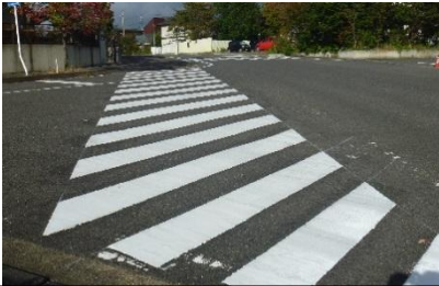
①横断歩道の道路標示が薄くなり見づらいため、横断歩道の引き直しを実施済 (H26)
