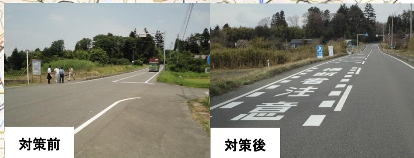
①下り坂でカーブしておりスピードが上がりやすい上に見通しが悪いいため、路面表示を設置済 (H26)
