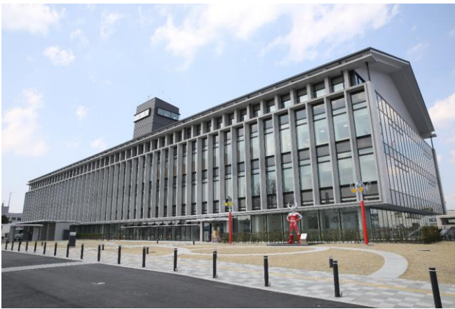
▲須賀川市新庁舎
