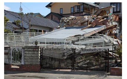
家屋の被災状況（南町地内）
