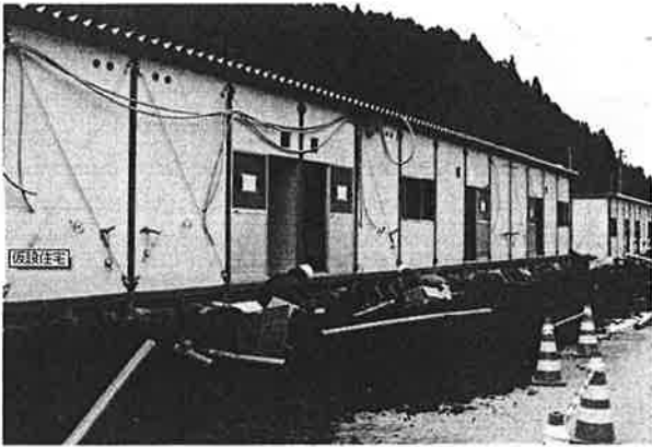
急ピッチで工事が進む仮設住宅
