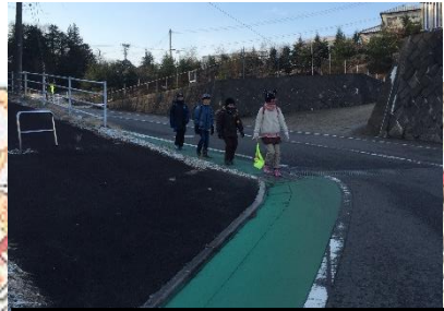
②道路が狭く歩道もないので路側帯カラーの再塗装を実施済 (H25)
