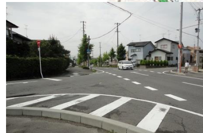
②車道が広くなり、交通量が増えたため、センターライン、ドットラインを設置済 (H25) 道路西側に横断歩道を設置 (H27)
