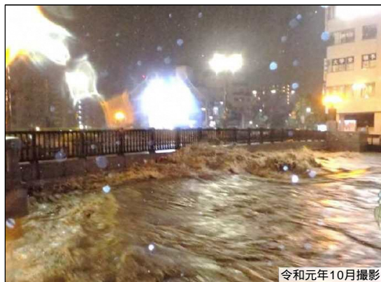
田川の溢水状況（JR宇都宮西口駅前 宮の橋）
