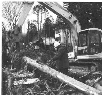
長沼溝地内の復旧作業
