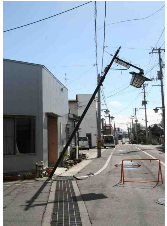
道路の被災状況（諏訪町地内）
