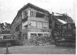
林精器の復旧作業 (3月24日)
