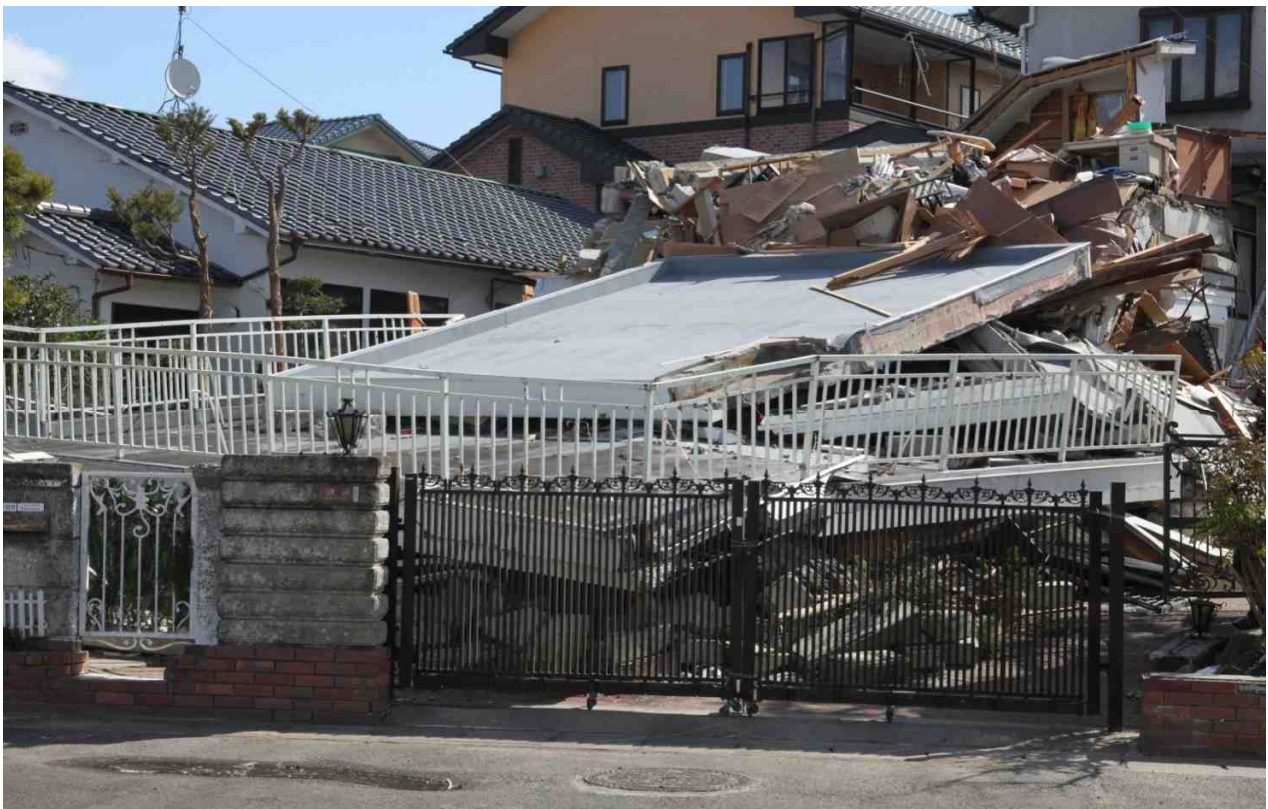
家屋の被災状況（南町地内）
