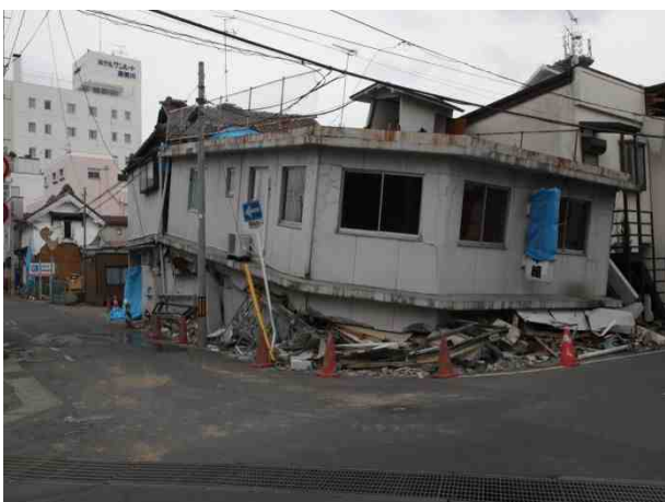
建物の被災状況（加治町地内）
