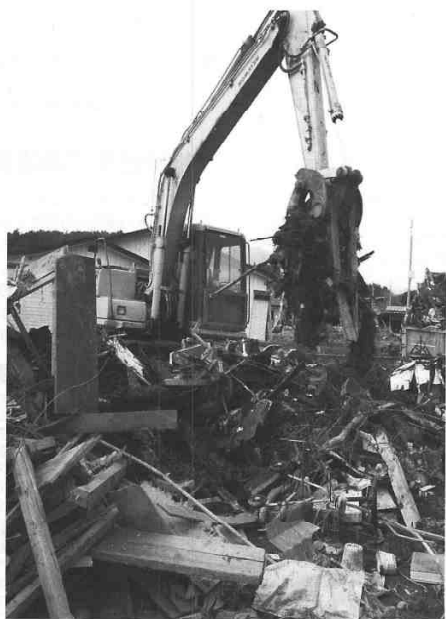
長沼北町地内の復旧作業 (長沼高校の東側)
