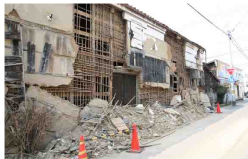
建物の被災状況（馬町地内）
