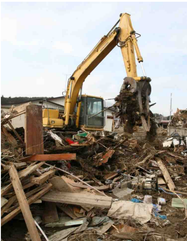
被災現場の復旧作業（長沼北町地内）
