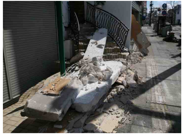
家屋の被災状況（中町地内）
