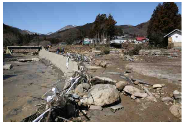
長沼地域・滝地内の被災現場
