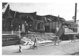
被災家屋の復旧作業 (南町地内・3月24日)
