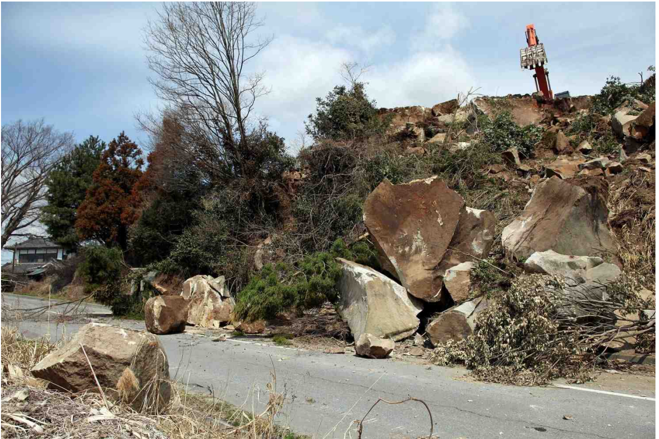
被災現場の復旧作業（江持地内）
