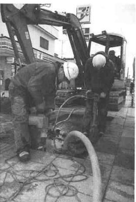
妙見地内の歩道の復旧作業
