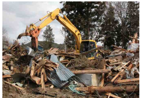
被災現場の復旧作業（長沼滝地内）
