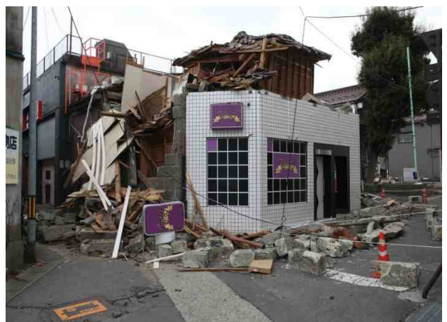
建物の被災状況（本町地内）
