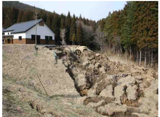
公共施設の被災状況（ふるさと体験館のり面）
