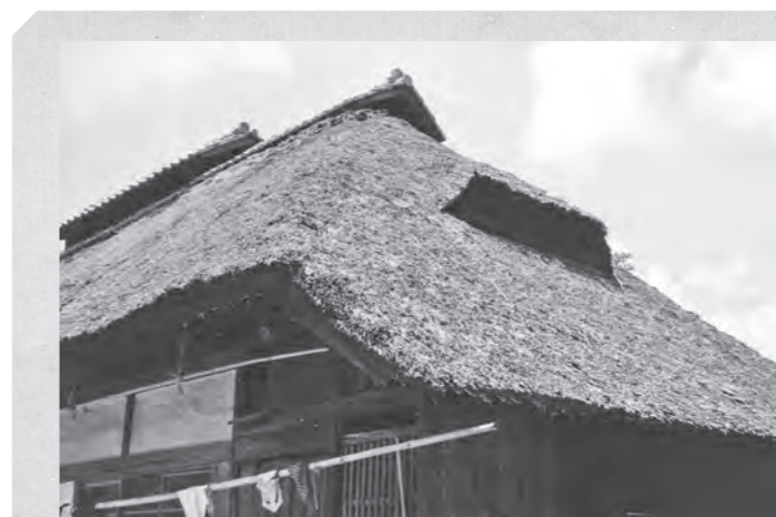
民家の茅葺き屋根と、一段高く設けられた煙出し
