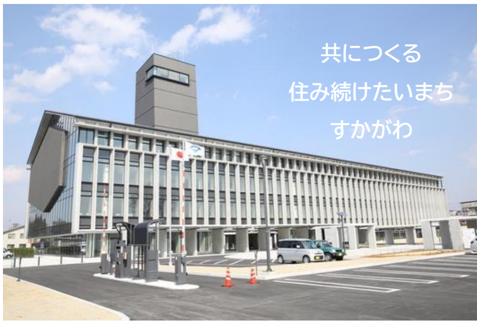
須賀川市役所
