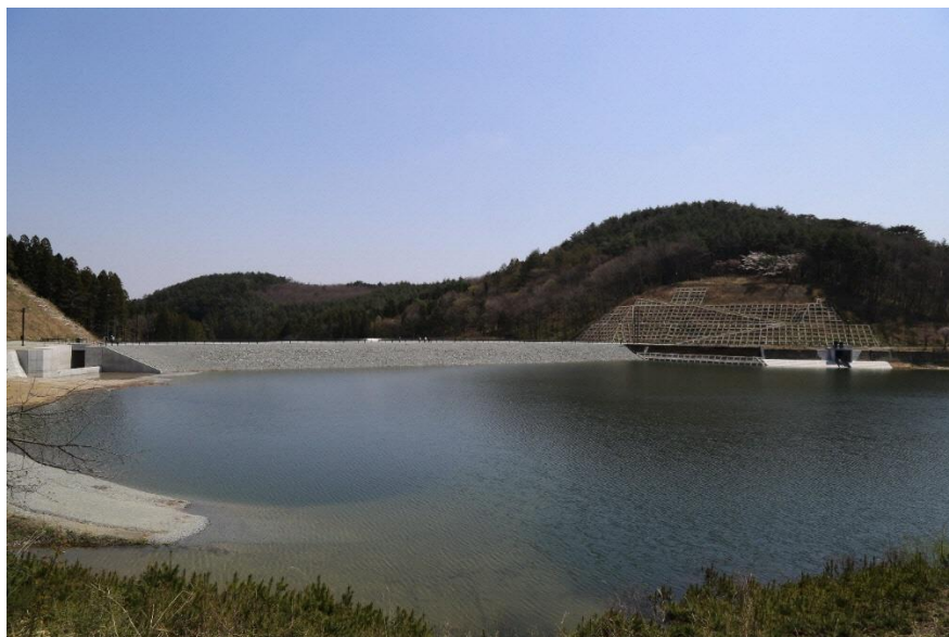
【藤沼ダム(復旧後)】
