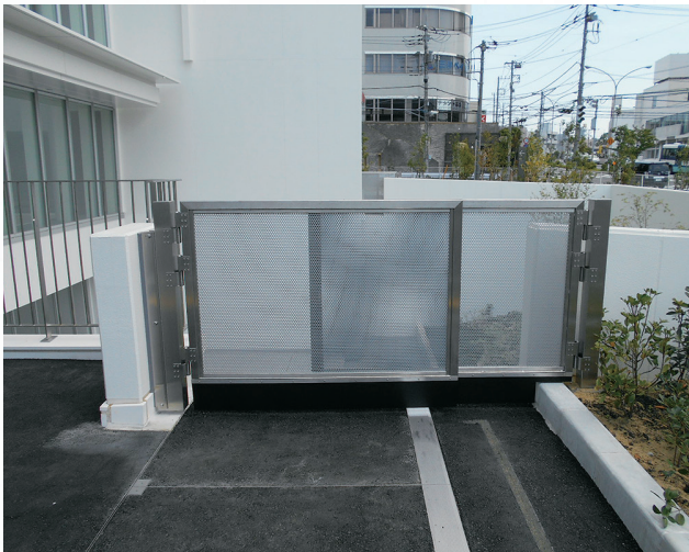
◀侵入防止柵 ステンレスパイプ クリアランス 500mm 可動量 ± 400mm
